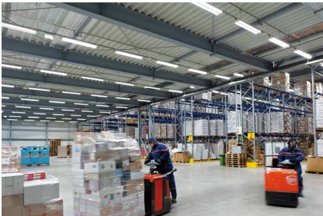
> NORKA-Leuchten für extreme Temperaturbereiche; hier -25°C in einem Tiefkühlager.
